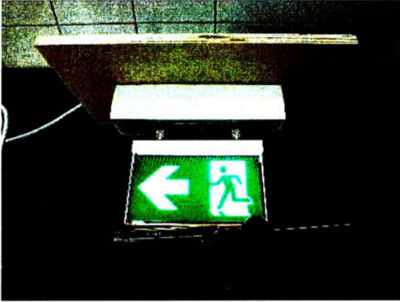
Bild 1 Ceruna (Rettungszeichen und Sicherheitsleuchte) mit genormtem Prüfdraht vor der Berührungsschutzprüfung IP5X
